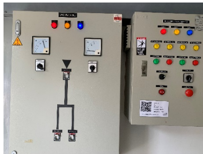
ตู้ควบคุม transfer pump
